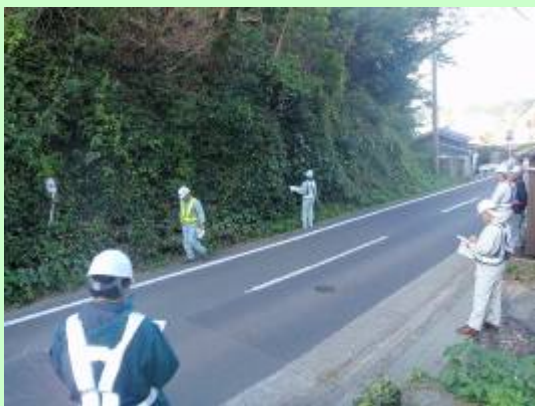
斜面点検の様子（その1）
