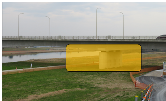
飛行ロボットによる橋梁点検位置(橋下のみ)
