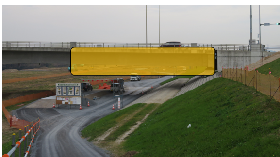
橋梁点検システム(クローラ台車)による橋梁点検位置
