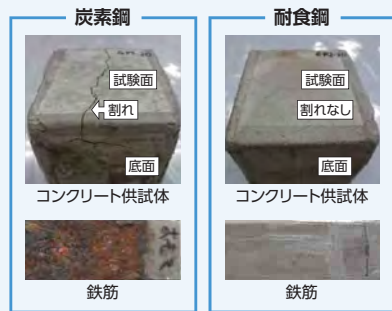
炭素鋼 腐食ひび割れが発生
