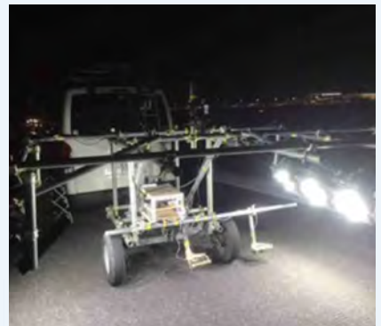
空港滑走路でのモニタリング現場実証の状況
